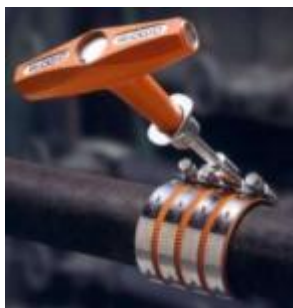
Mấu nối kẹp bằng thép được gắn chặt bằng một momen xoắn. Steel coupling connectors being tightened using a torque wrench.
